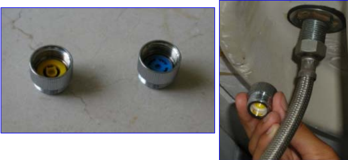
Fig. 5 Limitadores de caudal y adaptación en flexible
